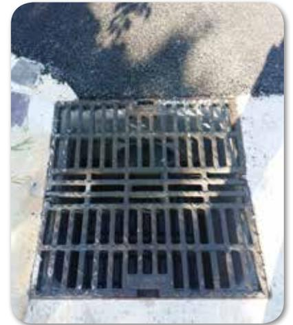
Route de Tournes, travaux d'assainissement au 654 : pose d'un regard avec grille concave.
