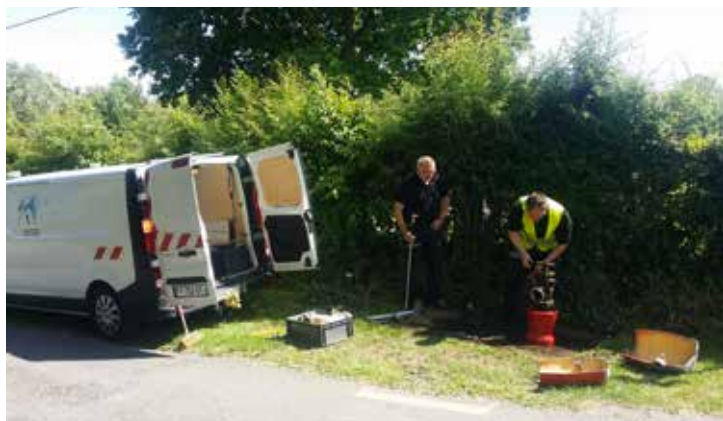
Contrôle et entretien des poteaux incendie par la société SICP
