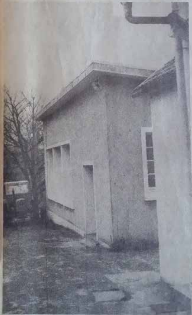
La salle des fêtes rénovée
